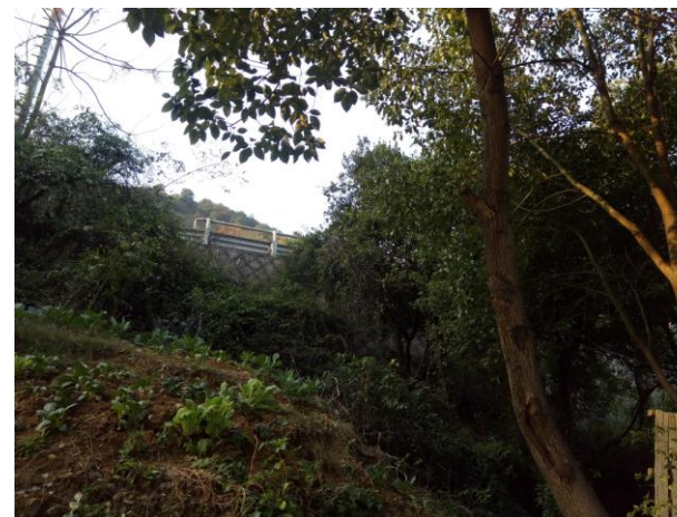
西北侧：温州绕城高速公路
