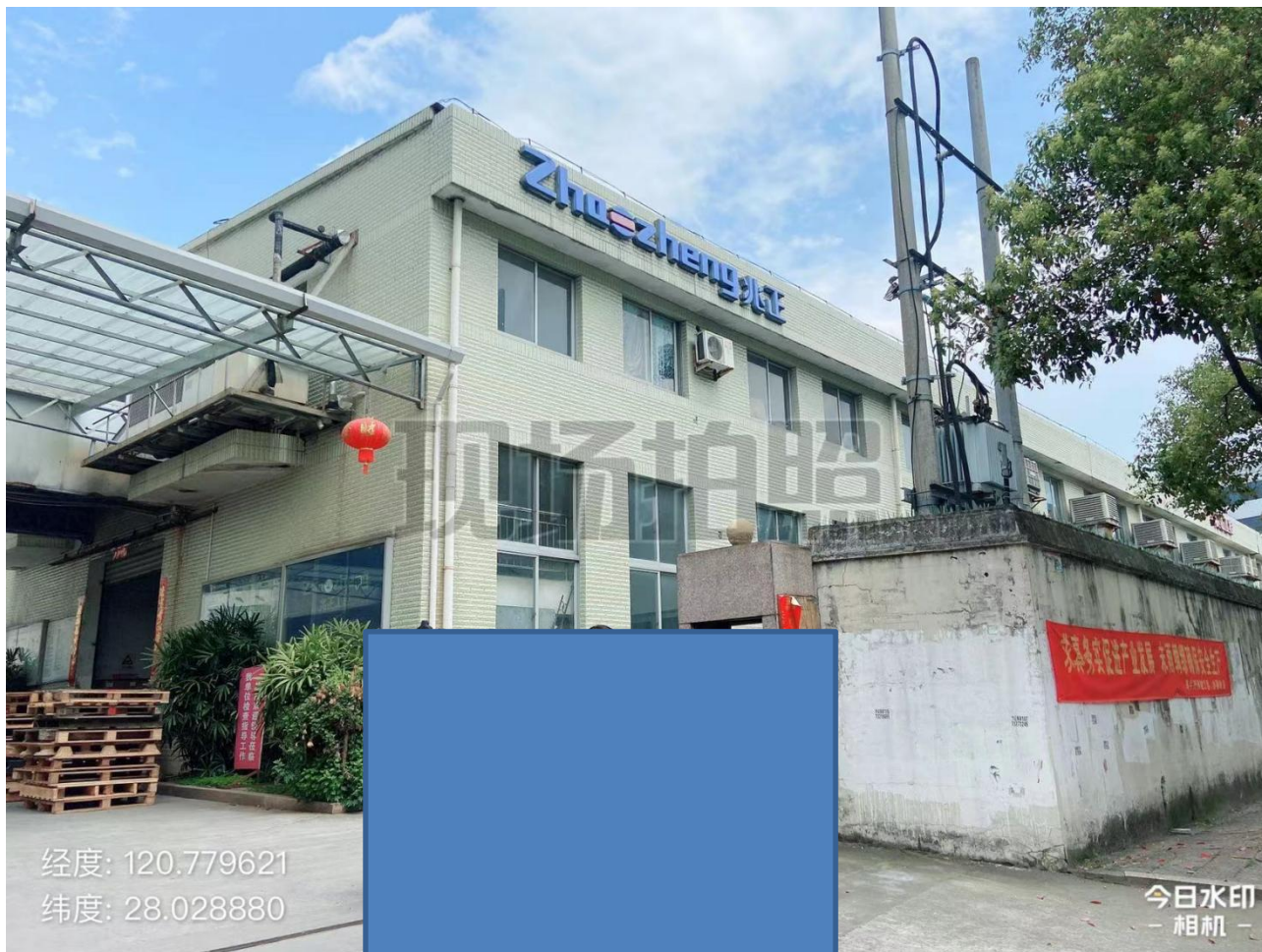
附图 1 编制主持人现场勘察照片
