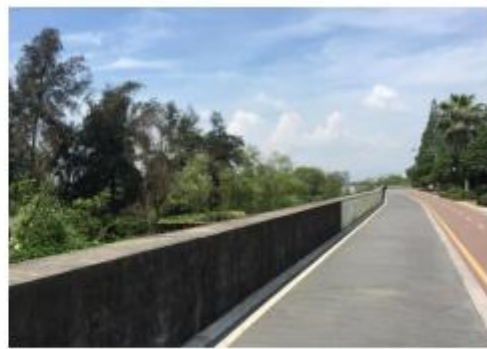
堤顶砼路面+沥青健跑道
