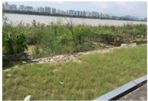
堤前块石镇压层
