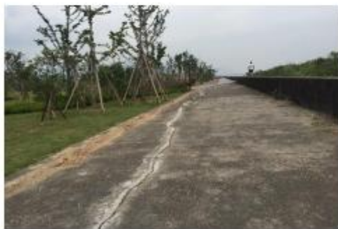
堤顶砼裂缝
