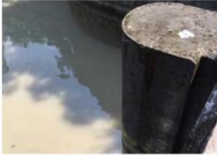
新桥水闸检修门闸墩
