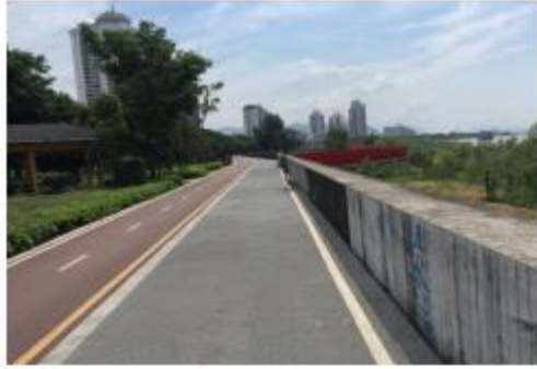
堤顶砼路面+沥青砼健跑道
