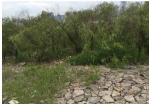
堤前块石镇压层
