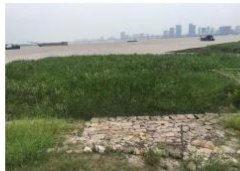
堤前块石镇压层
