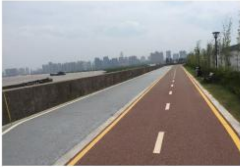
顶砼路面+沥青砼健跑道
