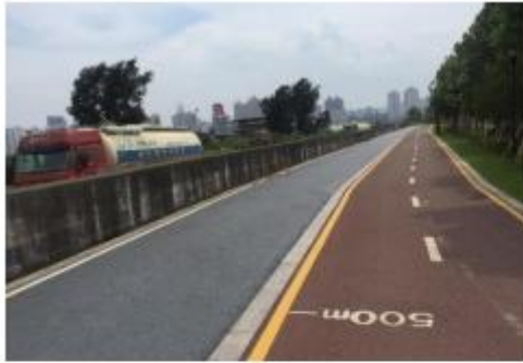
堤顶砼路面+沥青砼健跑道
