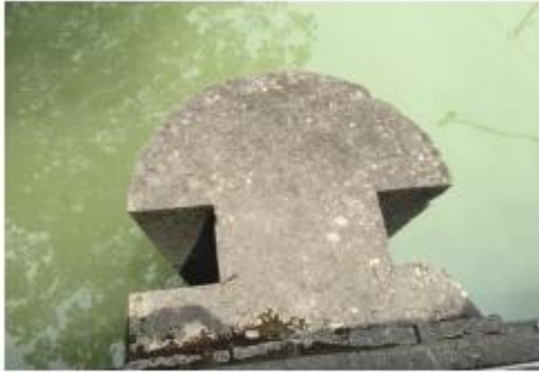
上游检修门槽
