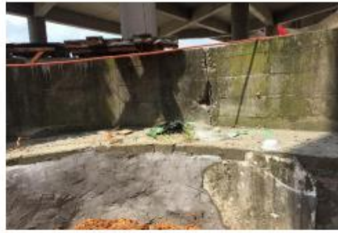
3#旱闸处堤顶宽度狭窄
