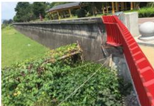
堤前块石镇压层
