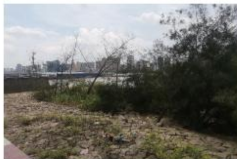
堤前块石镇压层
