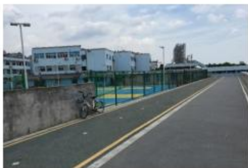
堤顶砼路面+沥青砼健跑道
