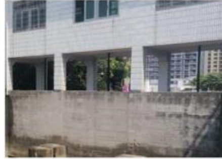
新桥水闸下游胸墙
