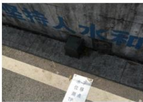
局部防浪墙与堤顶错开
