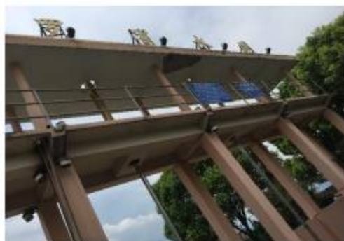
罗浦水闸上游立面
