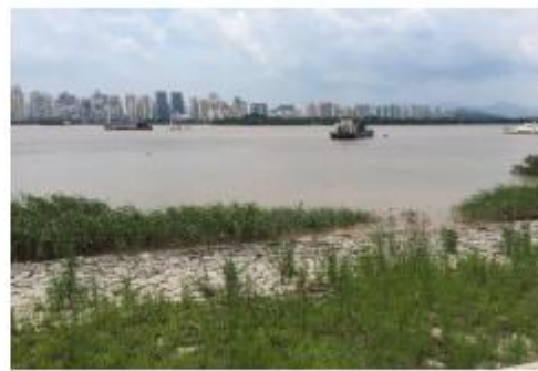
堤前块石镇压层
