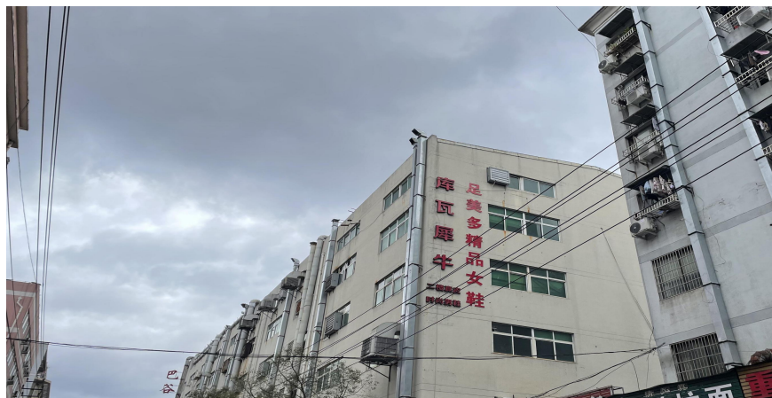
项目东侧：永嘉县蓝天龙鞋业有限公司厂房
